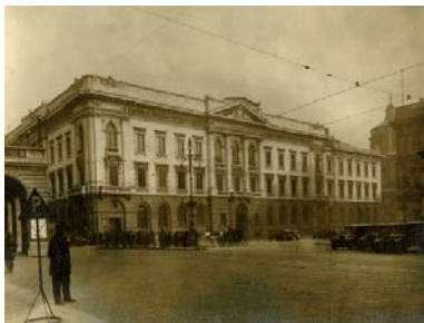
Milano, il palazzo della Banca Commerciale Italiana in piazza della Scala, sede della Direzione centrale, 1934
